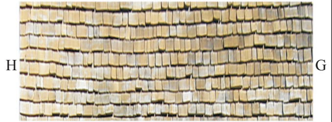
Top edge of Porch Roof
