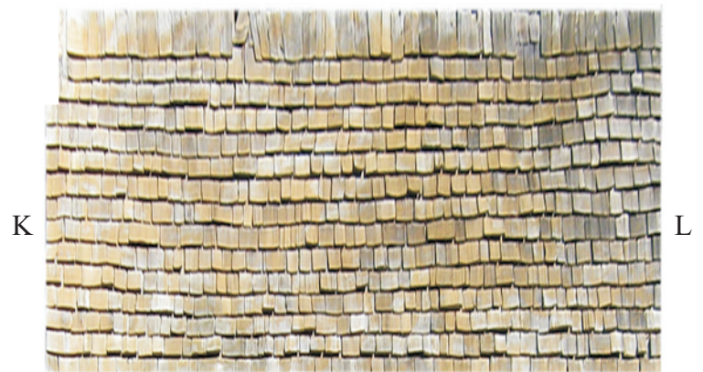
Bottom edge of Left Roof
